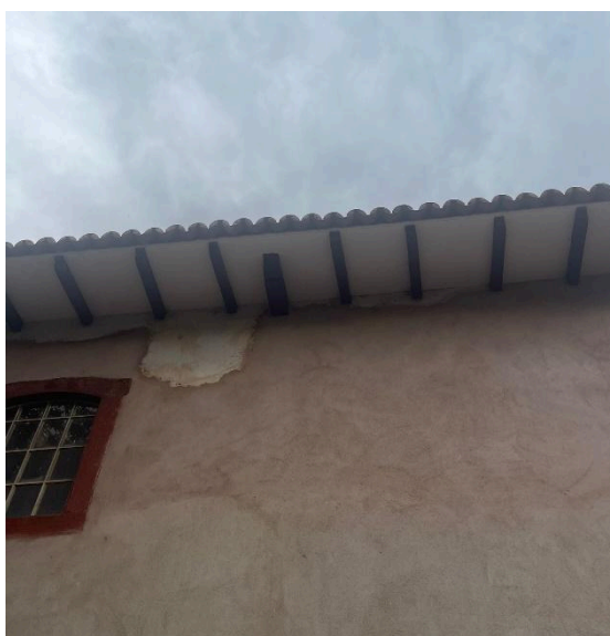
Acabamento dos beirais restaurados. Autoria: Eduardo Santos Data: 07/11/2024
