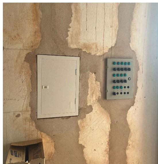
Quadros de distribuição de energia. Autoria: Eduardo Santos Data: 07/11/2024
