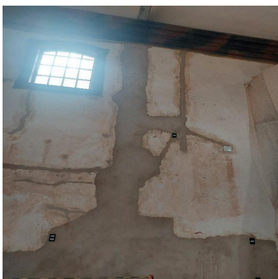
Detalhe da alvenaria após conclusão do restauro e das instalações elétricas. Autoria: Maria Leticia Ticle Data: 07/11/2024
